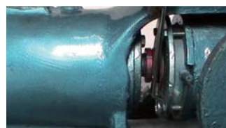
43. 对角均匀拧紧密封盒压盖上的紧固螺栓
